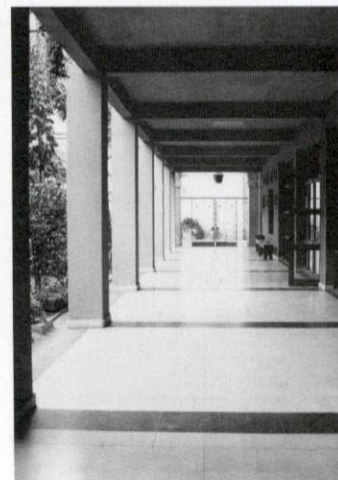
Foto 6: Corredor en el patio interior del Convento donde se realizaron principalmente los trabajos de limpieza.
