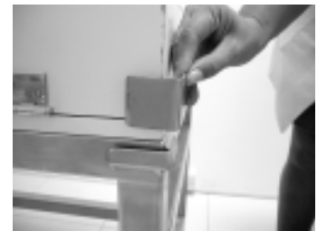
Foto 7. Sistema ajustable de protección dispuesto en las esquinas del estante-camilla, con el fin de impedir que las cajas se deslicen en caso de movimiento.
