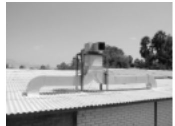
Foto 12. Vista general exterior del techo del depósito, donde se aprecian los ductos de ventilación.
