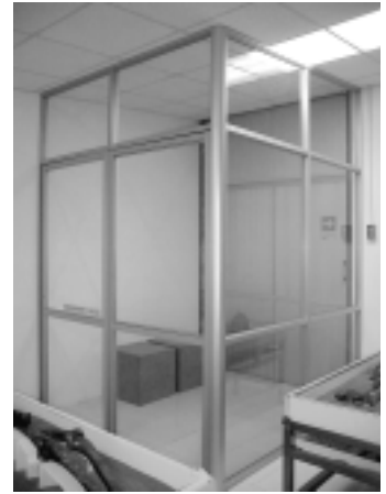
Foto 11. Cámara interior en el acceso al depósito. Cumple la función de barrera de amortiguación a los cambios externos, medioambientales.
