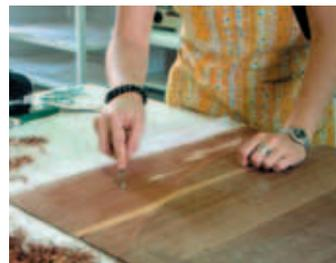
Foto 11. Desbaste del respaldo de madera estación N° II, 2002.
