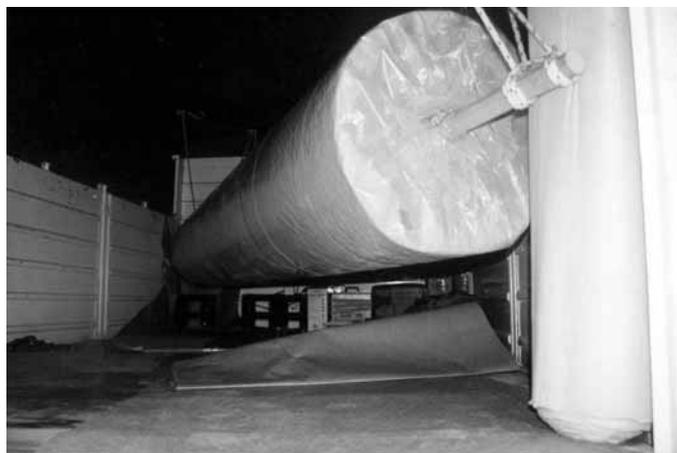
*Dibujo 3:* Disposición de las poleas para el descenso del cilindro con la tela desprendida.
