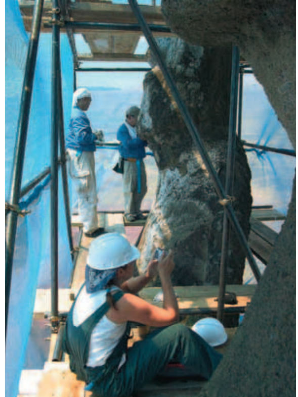
Foto 22 a y b. A, vista del moai 14 del Ahu Tongariki, durante el proceso de aplicación de consolidante. B, aplicación de producto hidrorrepelente. Proyecto UNESCO-Japón. 2004.
